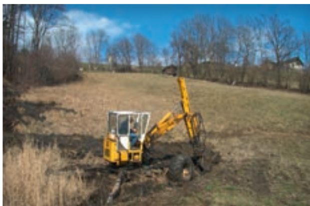
Notwendige Sanierungsarbeiten ( Drainage ) am Schulungsgelände Postleite im April 2015.
